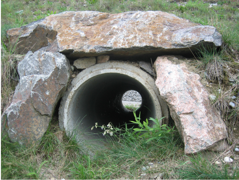
Abb. 2.6 Kleintierdurchlass (Foto: M. Trocmé).
