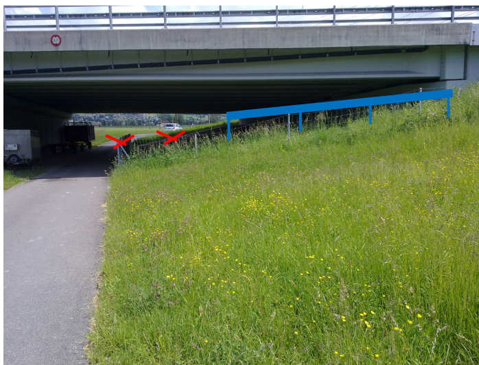
Abb. 3.1 Mit der angepassten Zaunführung (blau) und Chaussierung der strassennahen Bereiche des Widerlagers – Rot durchstrichen aktuelle Zaunführung, könnte hier die Durchlässigkeit für gewisse Wildtierarten gefördert werden (A53 bei Tuggen / Foto: A. Righetti).
