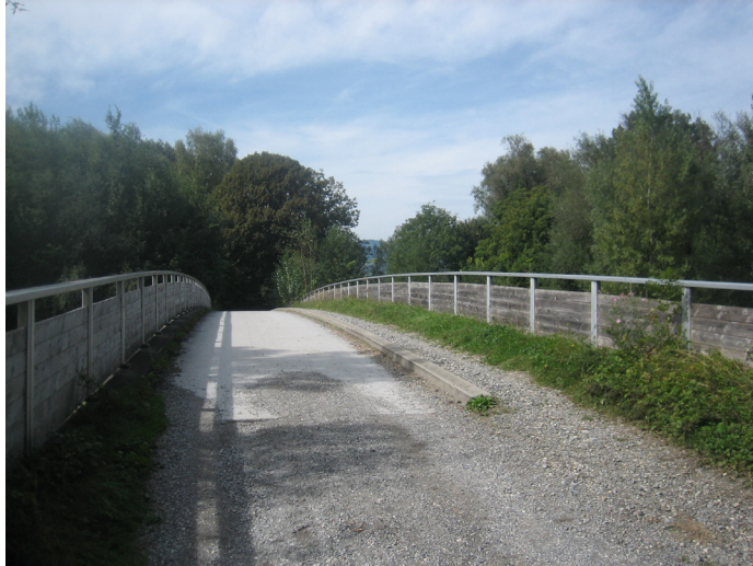
Abb. 2.2 Kunstbaute mit bewachsenem Trottoir (Überführung Fohlenhof A13 / Foto: M. Trocmé).
