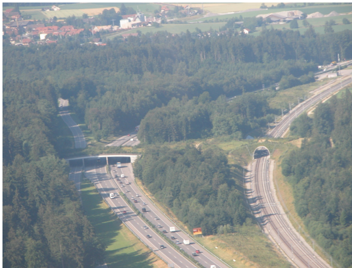
Abb. 2.3 Richtlinien- bzw. normkonforme Wildtierüberführung Birchiwald (A1) bei einem überregional bedeutenden Wildtierkorridor – links 50 m über die Autobahn, rechts 25 m über die 2-spurige Neubaustrecke SBB (Foto: Amrein).
