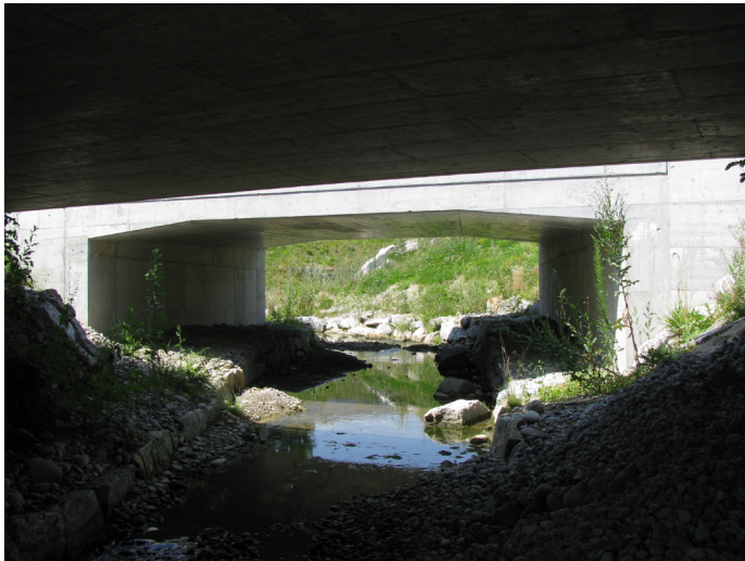
Abb. 2.1 Den Vorgaben der VSS Norm 640 696 [15] entsprechender Kastendurchlass.
