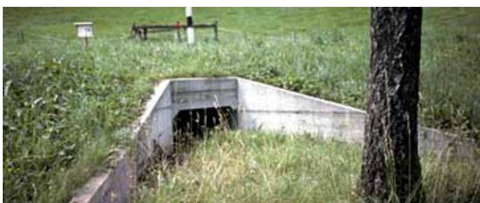
Abb. 2.5 Normkonformer Amphibiendurchlass (Foto: karch).
